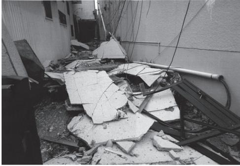
図2 途中ビルの外壁の崩壊
